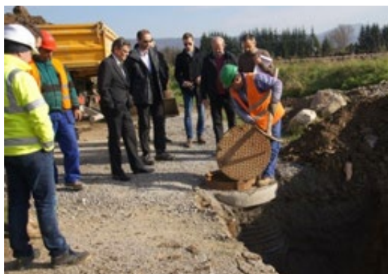
Končiace projekty kanalizácií a ČOV monitorovali zástupcovia úradu vlády a Veľvyslanectva Švajčiarskej konfederácie v SR
