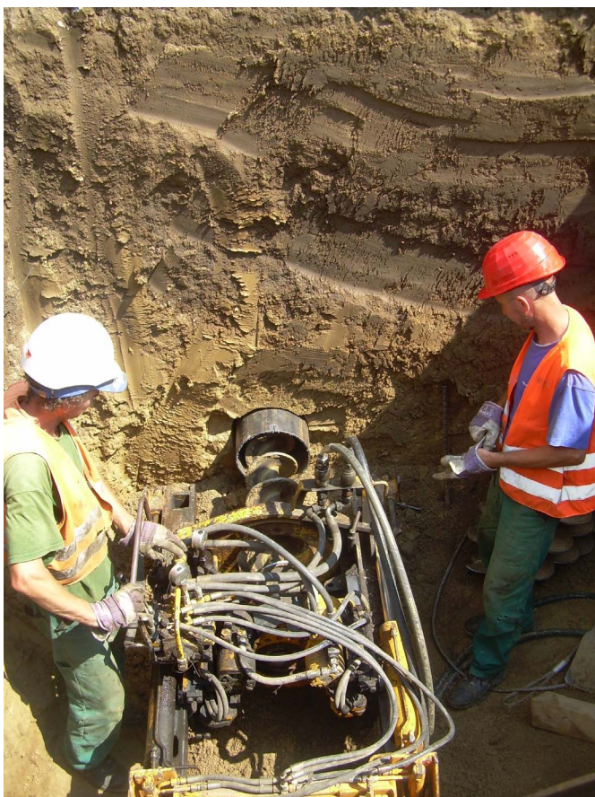
Výstavba kanalizácie v Dvorníkoch
